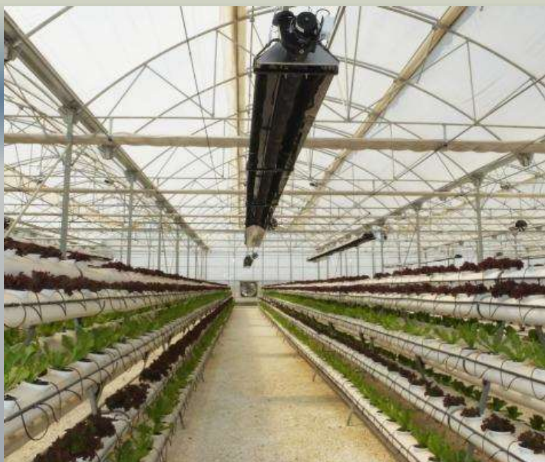
سیستم گرمایش تابشی در گلخانه کشت طبقاتی سبزی
